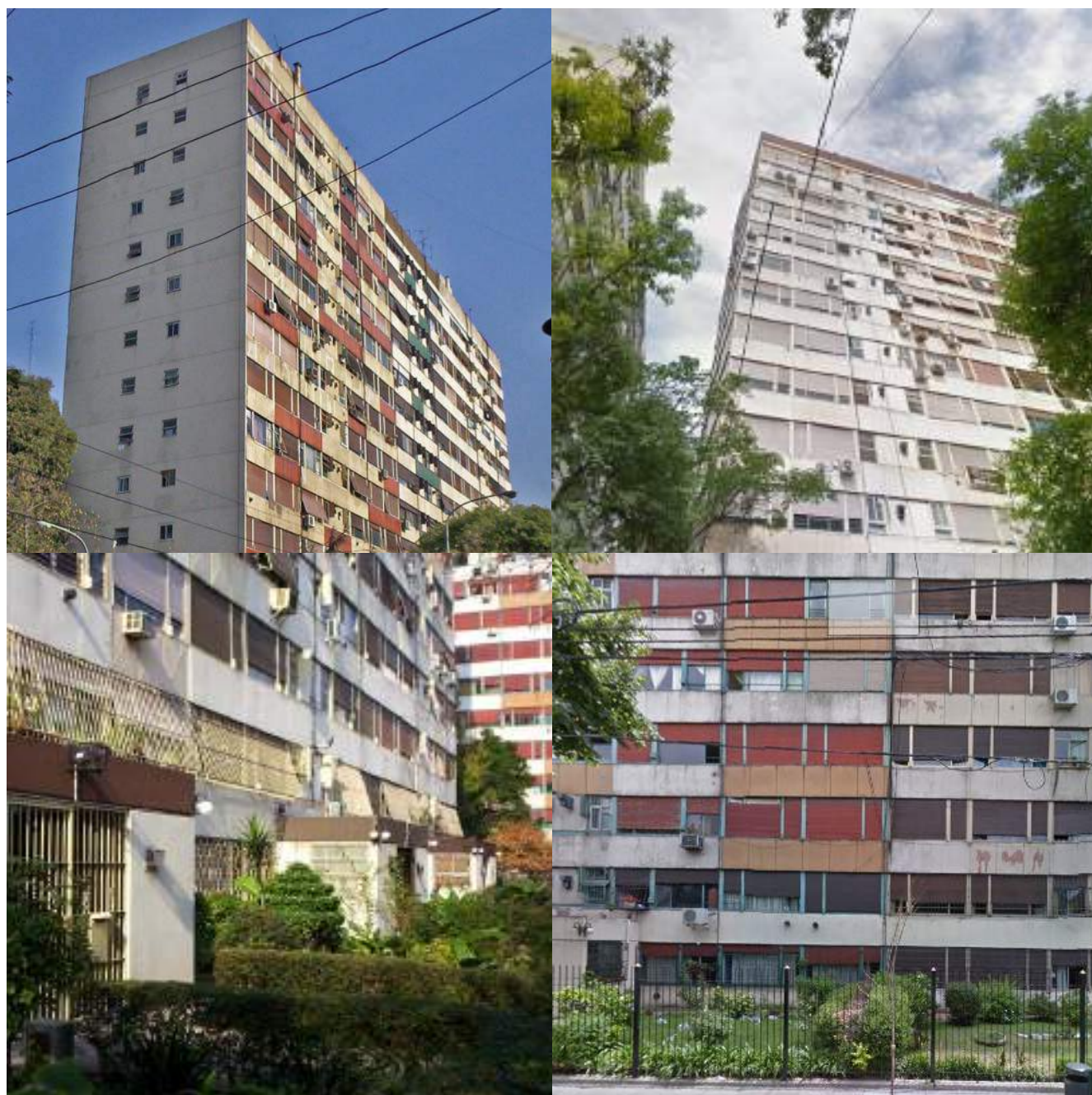
Fotografías peatonales del conjunto Urbano Constitución. San Cristóbal, Ciudad de Buenos Aires, Argentina. 1967. Fuente: Google Street View.
