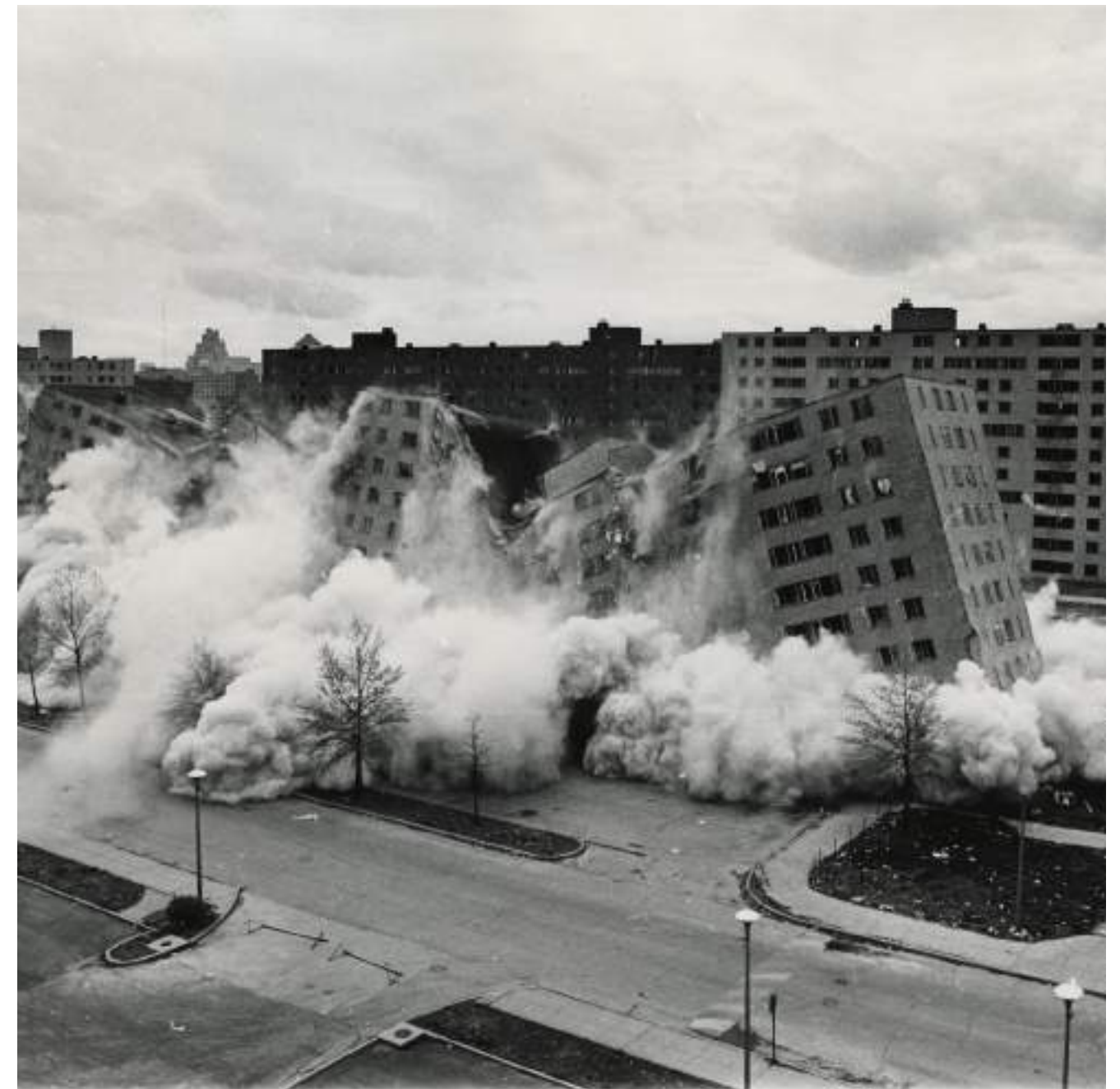
Demolición de Pruitt Igoe, San Louis, Misouri, EEUU. 21 de abril de 1972.
